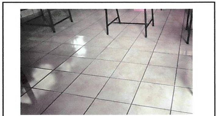
Foto 4: Sustitución de piso de granito por cerámico.
