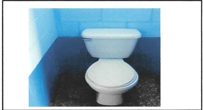
Foto 2: Sustitución de Rotoplast de 3,000 litros y cambio de accesorios de baños.
